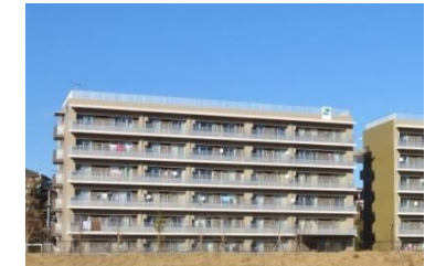
災害公営住宅 (宮城県石巻市)
