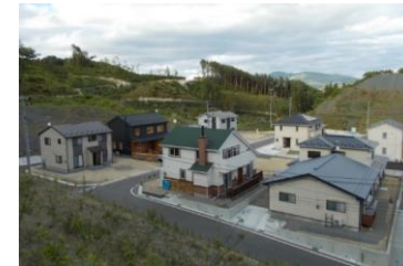
防災集団移転 (岩手県宮古市)
